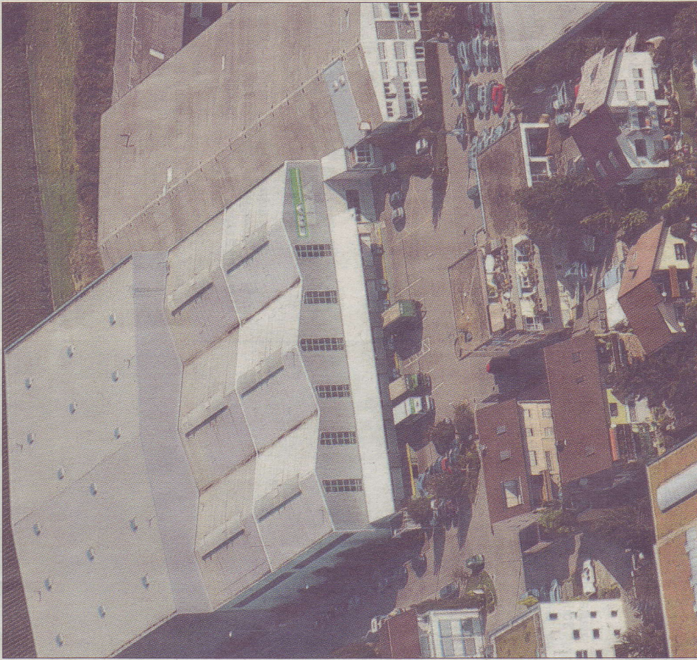
Seit drei Generationen in Kornwestheim: Era hat sich regelmäßig vergrößert. Zuletzt wurde das große Hochregallager gebaut.
